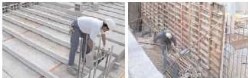
Figura 50 - Encofrador; manejo de cargas.
