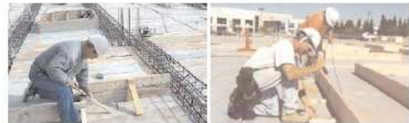
Figura 48 - Encofrador: posturas forzadas de piernas.
