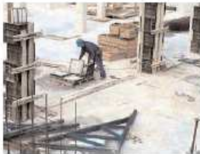
Figura 45 - Encofrador: recoger material a ras de suelo.
