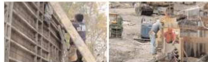
Figura 52 - Encofrador; trabajo sobre superficies irregulares.
