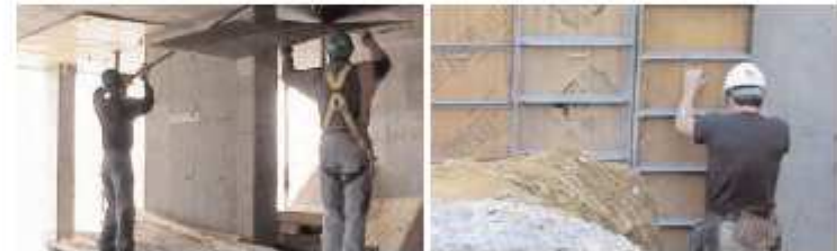
Figura 47 - Encofrador: brazos elevados (y sobre superficies inestables).
