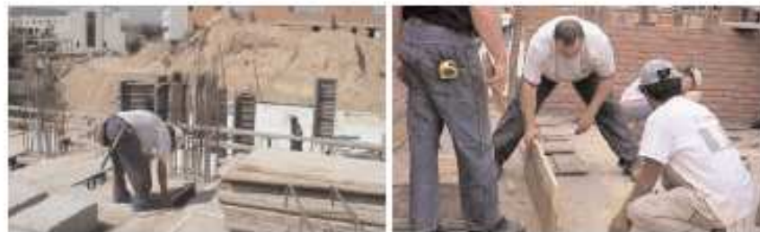
Figura 46 - Encofrador: trabajo a ras de suelo.
