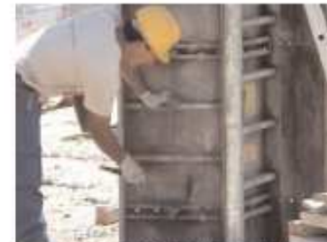
Figura 51 - Encofrador; fuerza impulsiva
